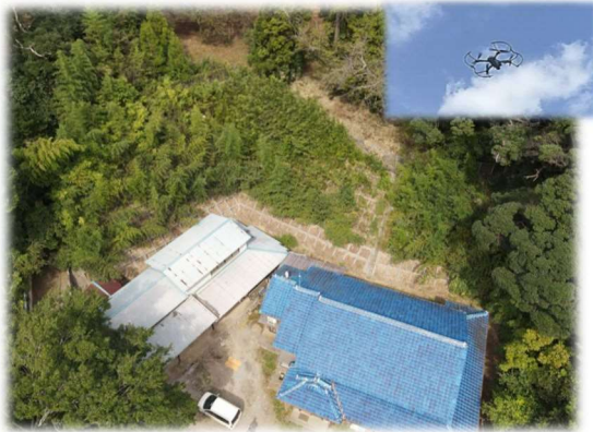
UAV（ドローン）による撮影（立入り困難範囲）
