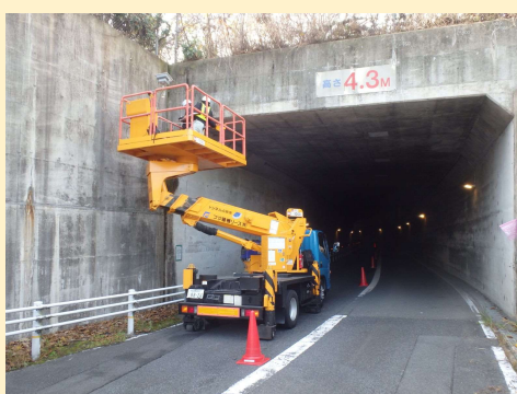
カルバート・擁 壁
