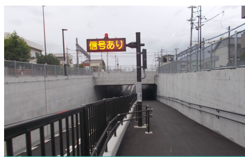
路面冠水情報表示設備設計
